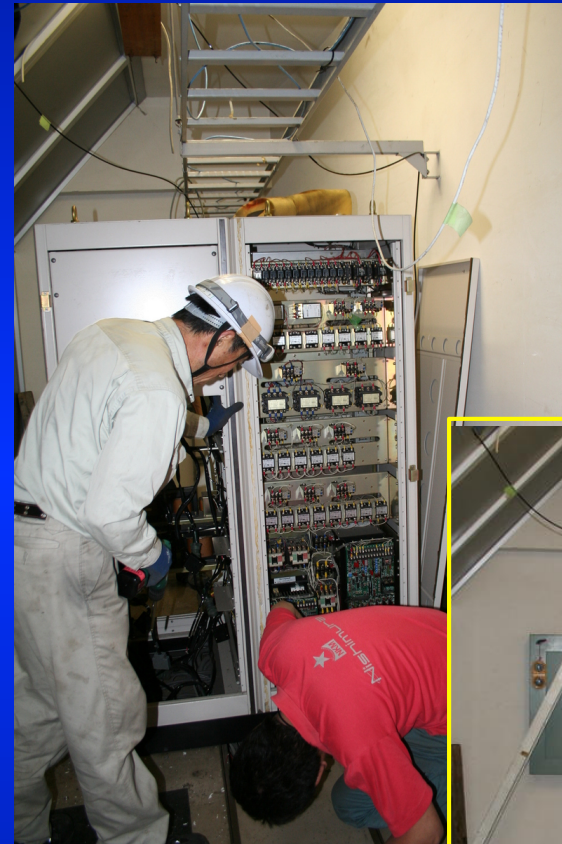
パワーリレー室
