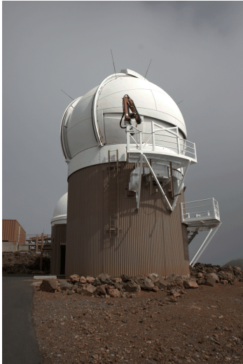
Figure 4: ハレアカラ山頂に設置された PS1 望遠鏡。2008 年 11 月に ORR を達成する予定で、その後に 3\pi Steradian Survey を開始する。2008 年 11 月撮影。
