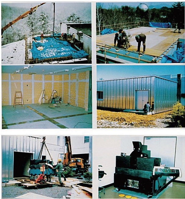
画像処理室の新設とPDS2020GMSの搬入
