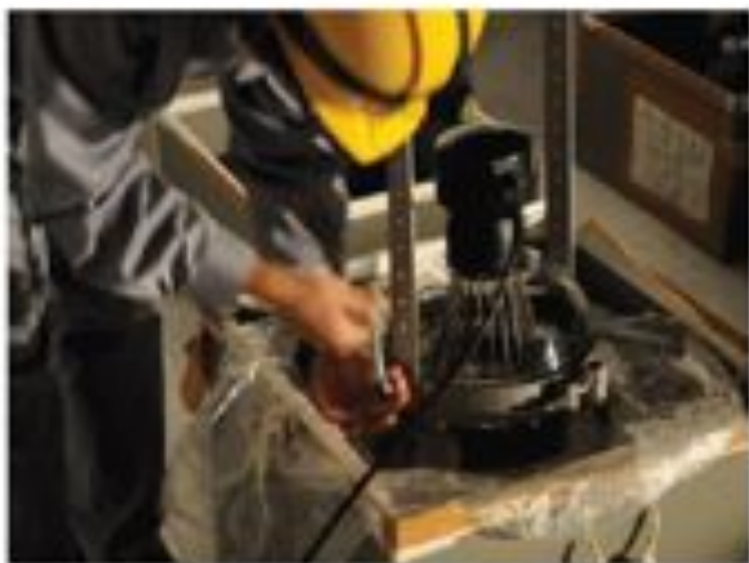
支持金具の取り付け
