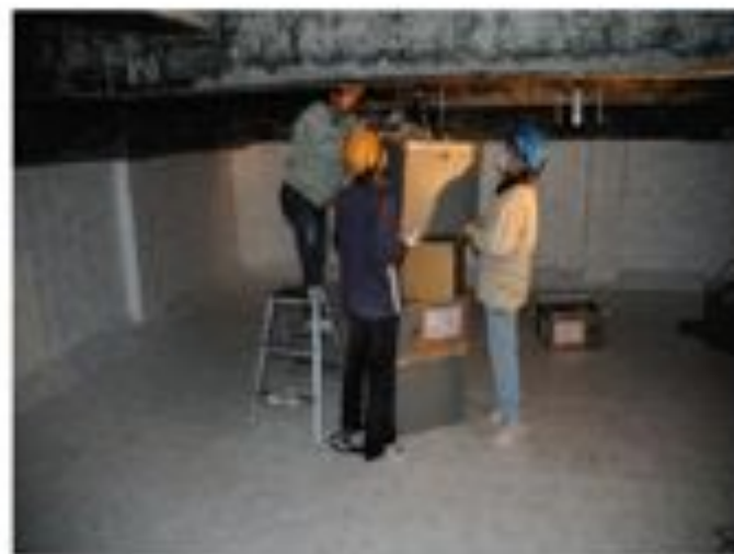
天井への取り付け
